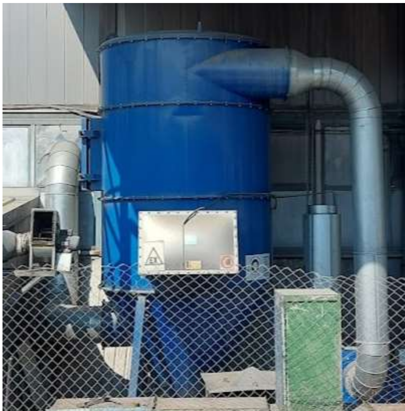
Слика 19 Филтер од пескара Coral
